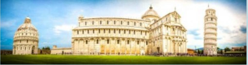
Que foi construída para receber o sino da igreja, é inclinada por ter sido construída em um terreno pouco firme, de areia e argila.
